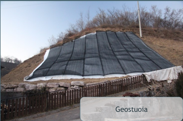
Reti e chiodatura del terreno
