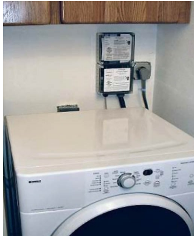
Figura 4.3 Esempio di asciugatrice integrata con un " demand response switch " per il controllo della richiesta elettrica
