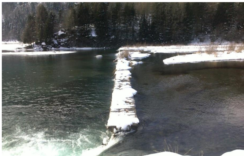
Figura 6.17: Opera di difesa trasversale adibita a intercettazione di sedimenti, che segna il confine tra il Cordevole ed il lago di Alleghe.
