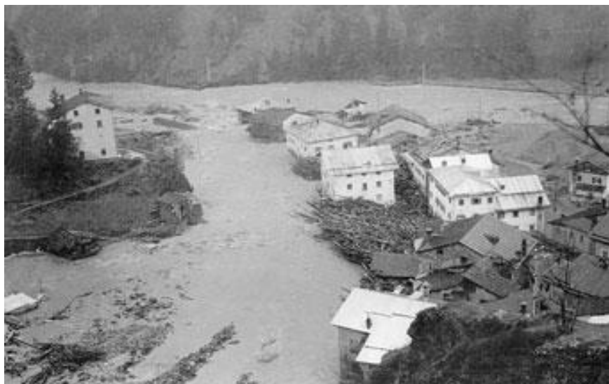
Figura 6.9: Caprile dopo l'alluvione del 1966 alla confluenza del torrente Fiorentina con il Cordevole. Si noti la quantità di legname trasportato dal torrente durante la piena. Il ponte sul torrente Fiorentina, travolto dai detriti, venne distrutto (HOTELPOSTA.COM).
