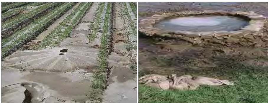
Fig. 1.9: Esempio di formazione di fontanazzi e protezione con sacchi di sabbia
