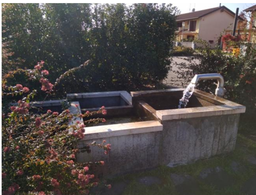
Figura 5.3: pozzo comunale localizzata in località “Al Palazzon” in Via Caduti Nei Lager, Sambughè di Preganziol.
