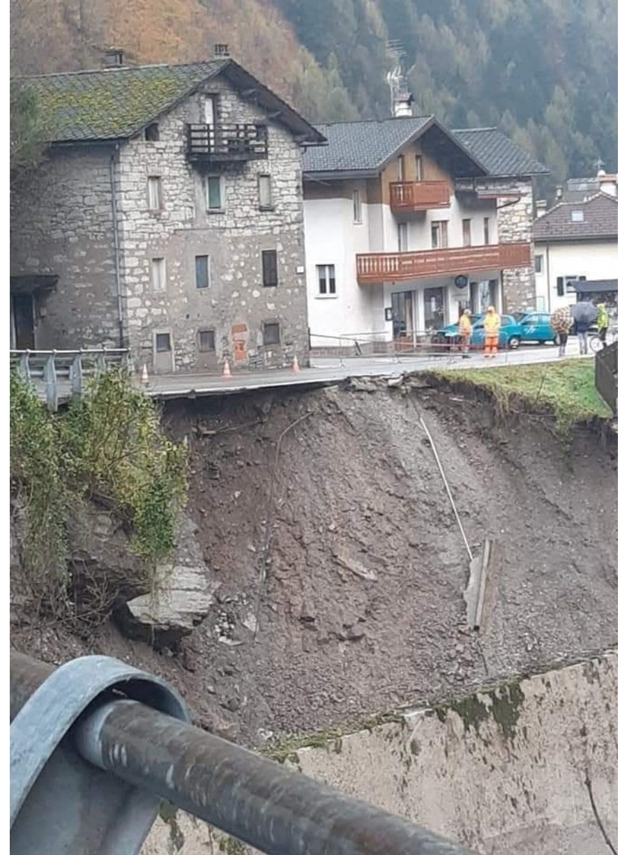
Cencenighe, fiume Cordevole, erosione delle sponde e crollo di parte della strada.
