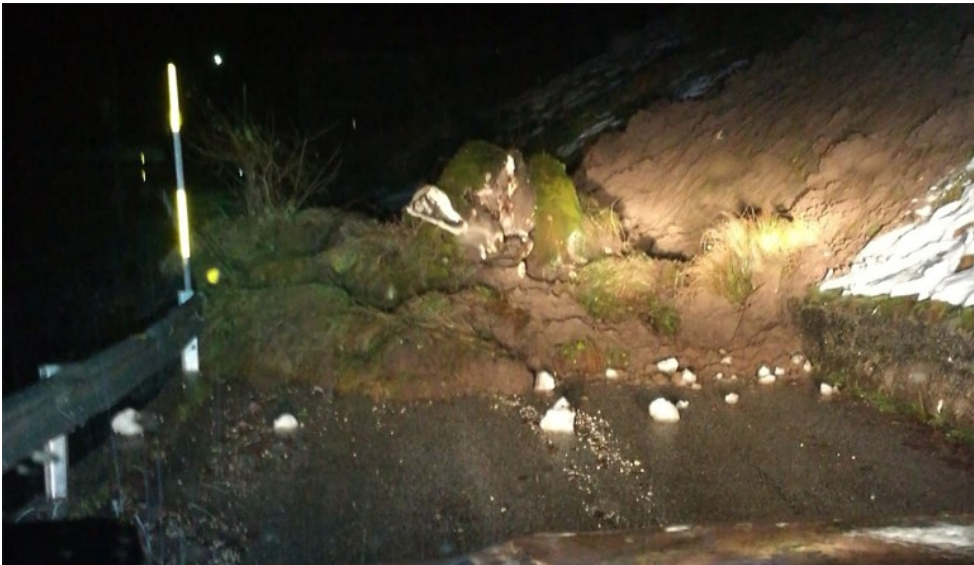
San Tomaso Agordino, novembre 2019. A causa del maltempo si riattivano frane dell'anno precedente, isolando la frazione di Canacede.
