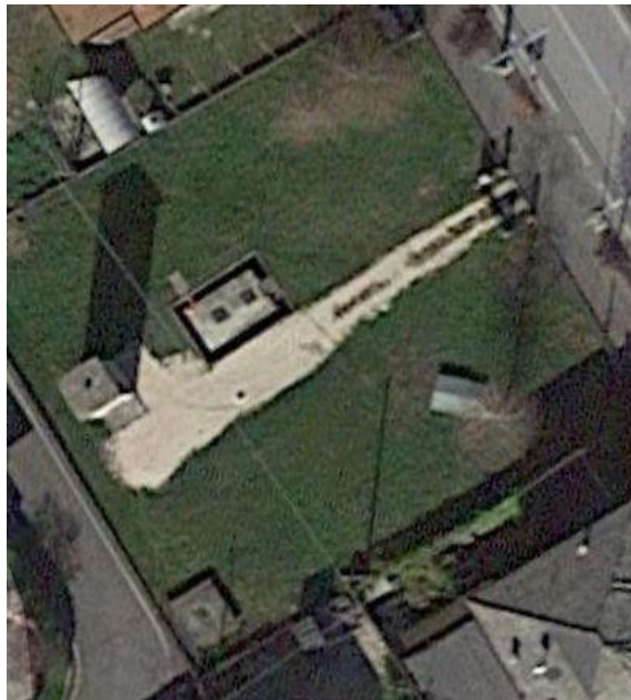
Figura 5-22: Vista aerea del Sito 3 (Fonte: www.maps.google.it )
