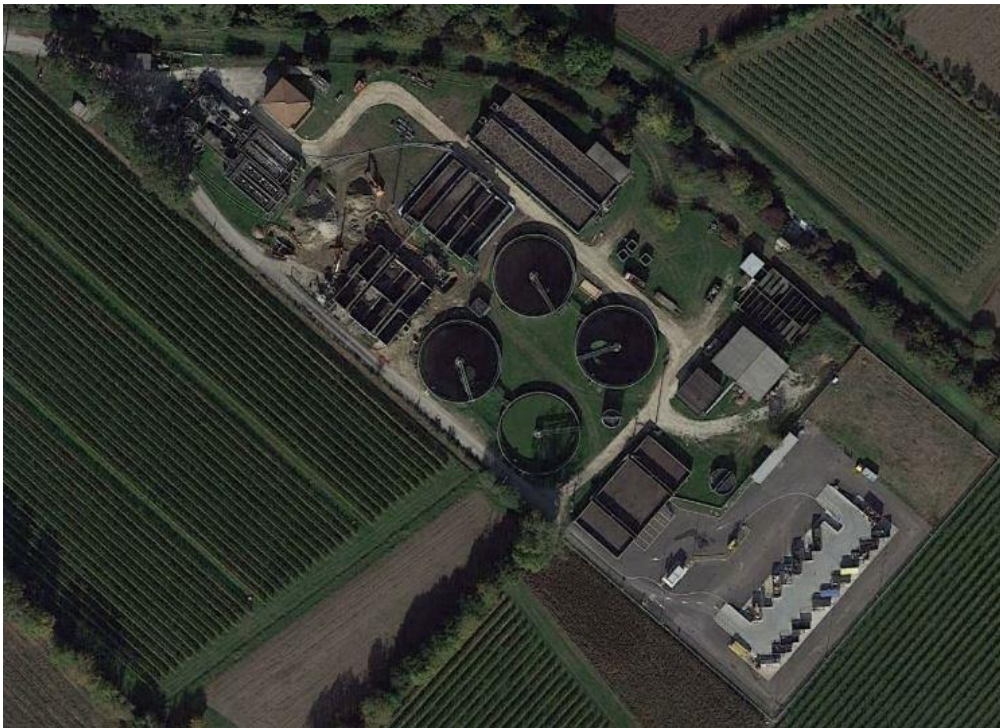
Figura 5-3: Vista aerea del depuratore del Sito 1 (Fonte: www.maps.google.it )
