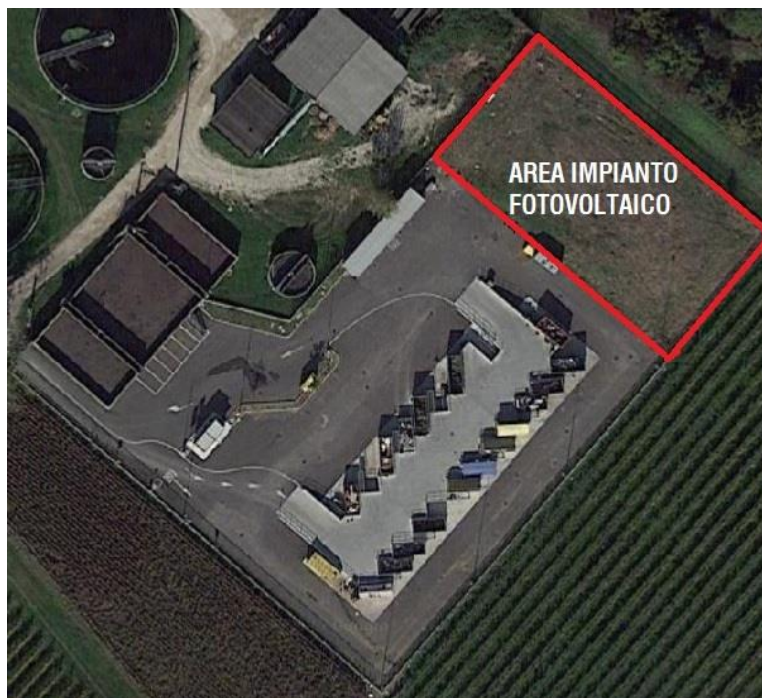
Figura 5-11: Area impianto fotovoltaico - Sito 1 (Fonte: www.maps.google.it )
