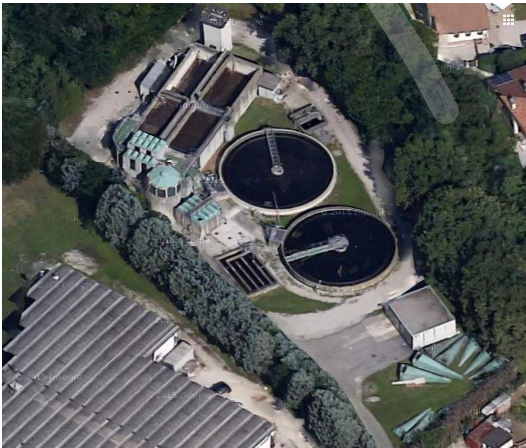
Figura 5-32: Vista aerea del depuratore del Sito 4 (Fonte: www.maps.google.it )
