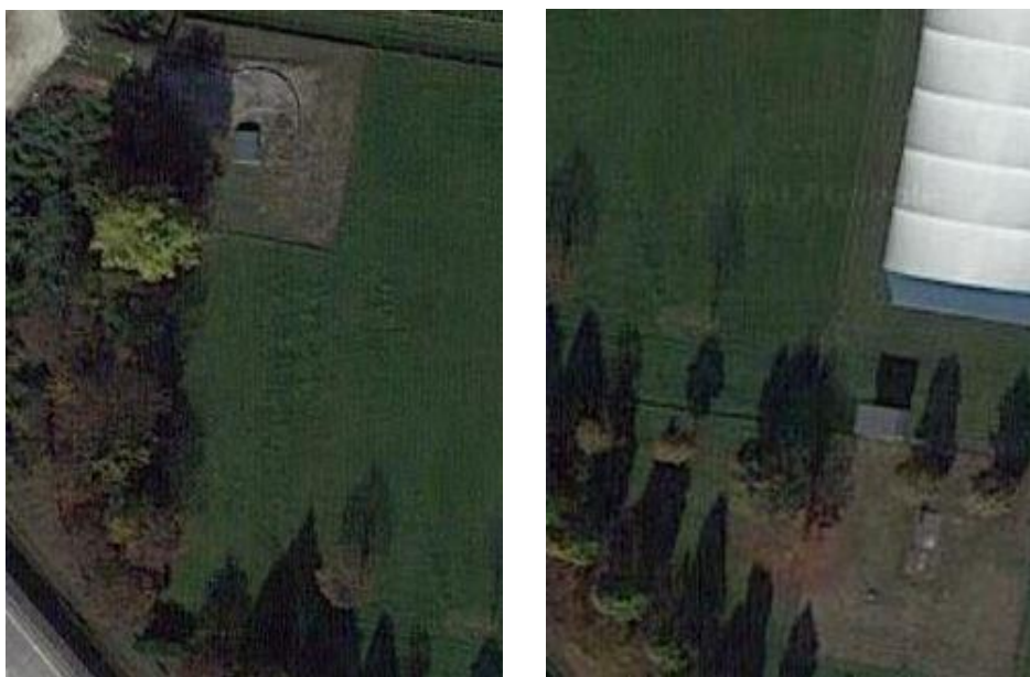
Figura 5-41: Vista aerea del Sito 5 (Fonte: www.maps.google.it )
