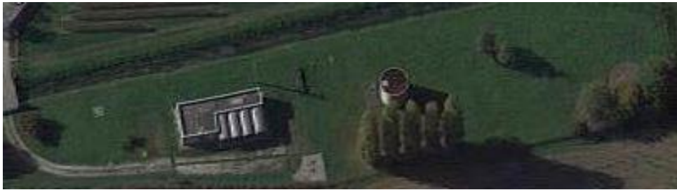
Figura 5-13: Vista aerea del Sito 2 (Fonte: www.maps.google.it )
