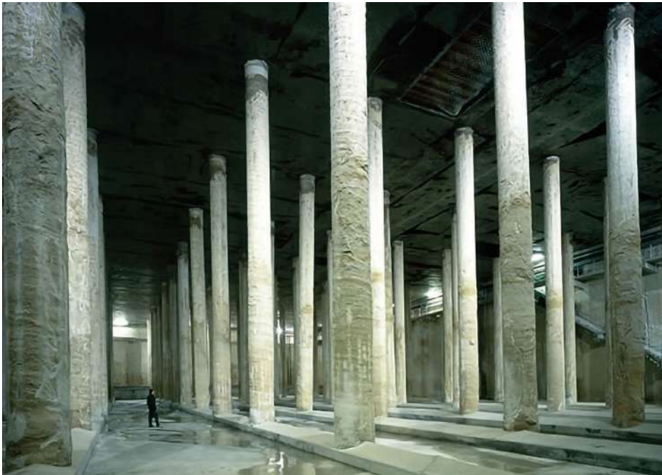
Fig.2 Deposito de retencion de agua de lluvia Juan Mirò.
