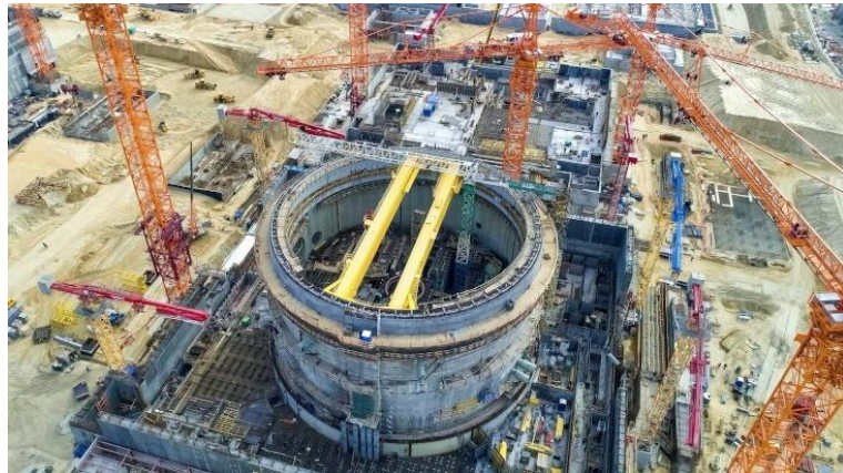
Installazione del contenitore a pressione in Kursk 2-1
