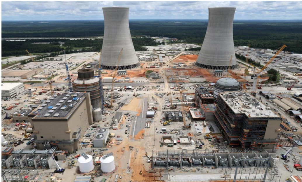
Foto del sito di costruzione delle due unità Vogtel 3&4, 2020.
