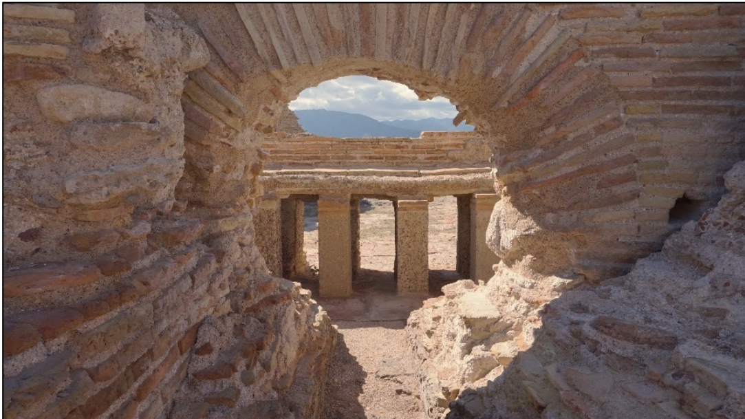
Fig. 3.2.6. Intercapedine del praefurnium con ricostruzione delle suspensurae , su cui poggia la pavimentazione della vasca del laconicum/tepidarium (vano G).
