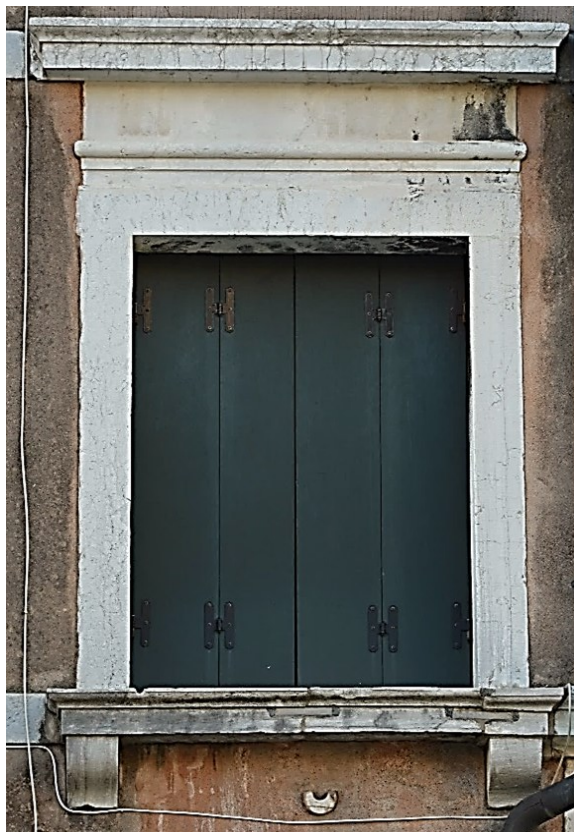
Fig. 18 Dettaglio monofora del piano ammezzato , composta da un architrave, sul quale si imposta un liscio fregio e una cornice modanata; presenta un davanzale modanato sostenuto da semplici mensole aggettanti.
