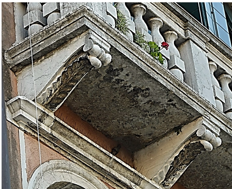
Fig. 22 Dettaglio mensole con motivi vegetali a sostegno dei poggioli delle trifore. Foto dell'autrice.
