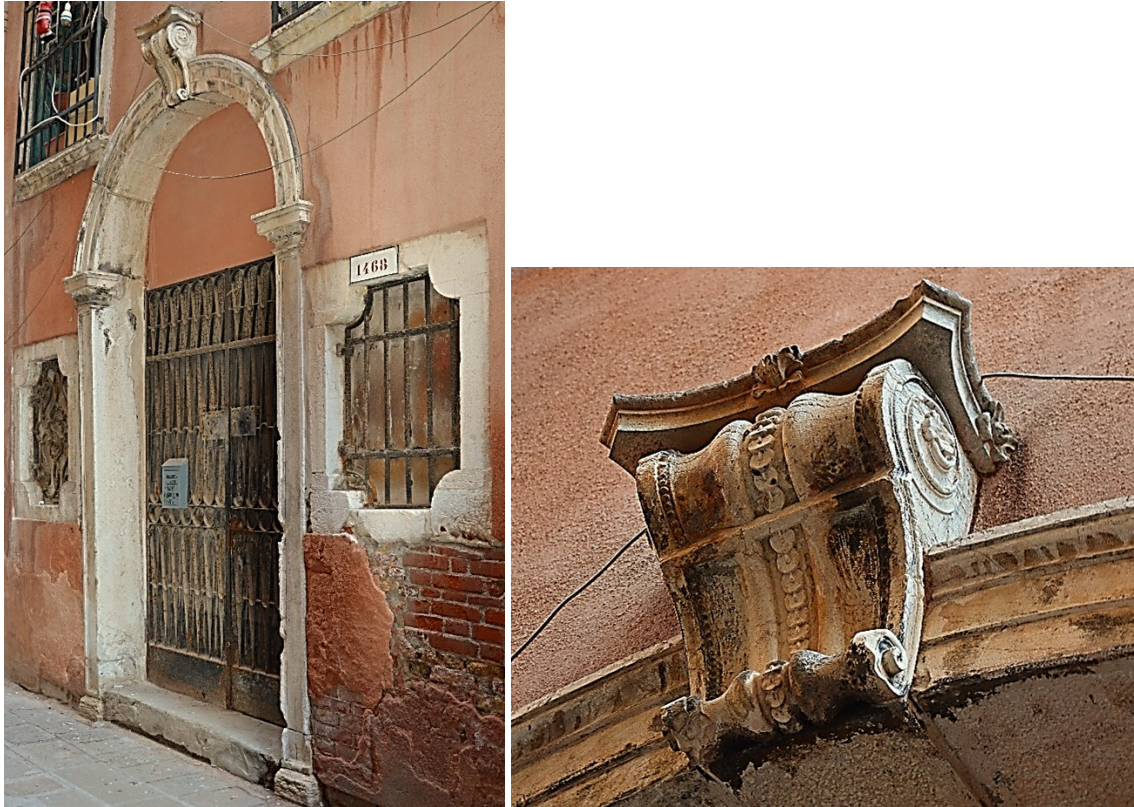
Fig. 26 Dettaglio del portone d'accesso via terra e della chiave di volta da calle del Porton vicino al rio del Ghetto, oggi in disuso. Foto dell'autrice.
