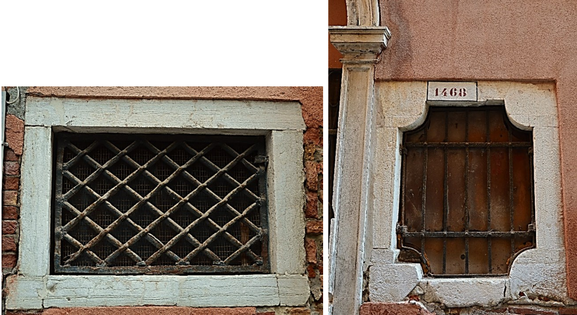
Fig. 27 Dettagli delle finestre «da luze» del piano terra poste ai lati degli accessi su calle del Porton. Foto dell'autrice.
