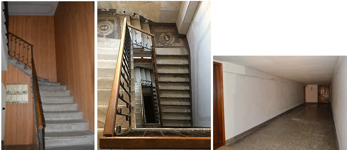
Fig. 33 Dettaglio del vano scale che dal pianoterra conduce fino al livello dell'ammezzato di sottotetto. L'accesso a queste scale avviene tramite il portone principale in calle degli Ormesini. Nella foto di sinistra si vede l'androne, che dall'ingresso immette alle scale; nella foto centrale si vede l'intera tromba di scale vista dall'alto; nella foto di destra si vede il corridoio condominiale, situato a livello dell'ammezzato di sottotetto, in cui si aprono altre cellule abitative. Foto dell'autrice.
