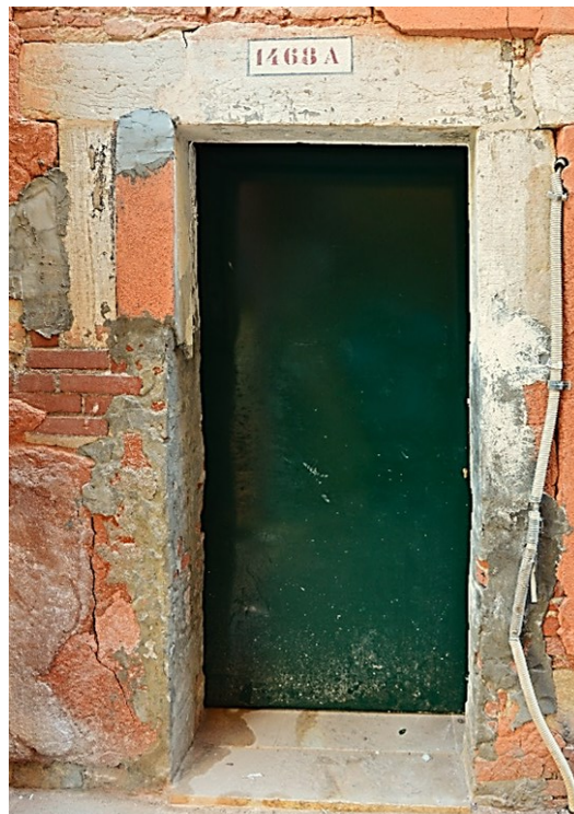
Fig. 28 Dettaglio di un portale d'accesso via terra secondario da calle del Porton, esso presenta una struttura trilitica. Foto dell'autrice.
