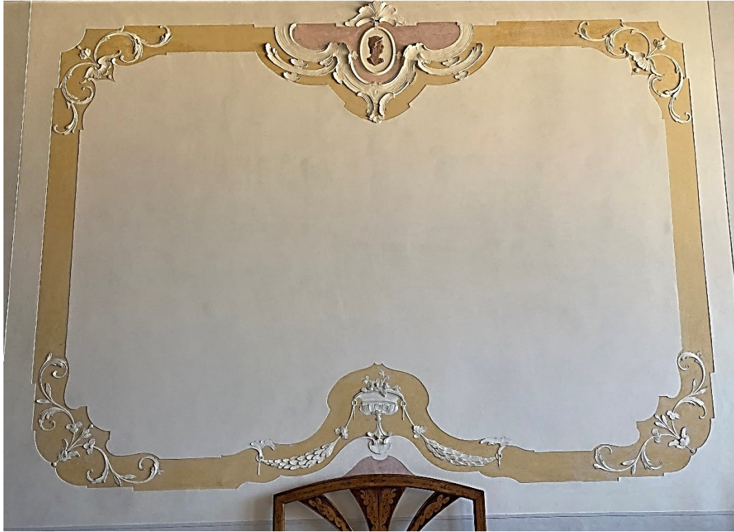
Fig. 73 Dettaglio delle pareti longitudinali del «portego» con affaccio a trifora e poggiolo sul rio di San Girolamo, a destra del secondo piano nobile. Foto dell'autrice.
