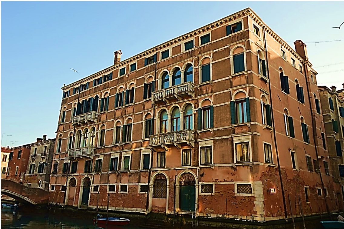
Fig. 15 Palazzo Treves dei Bonfilii in Ghetto Nuovissimo, sestiere di Cannaregio, Venezia; l'edificio si staglia all'angolo tra i rii del Ghetto e di San Girolamo, a sinistra si può intravedere il ponte degli Ormesini, che collega la omonima fondamenta con l'odierna calle degli Ormesini. Foto dell'autrice.
