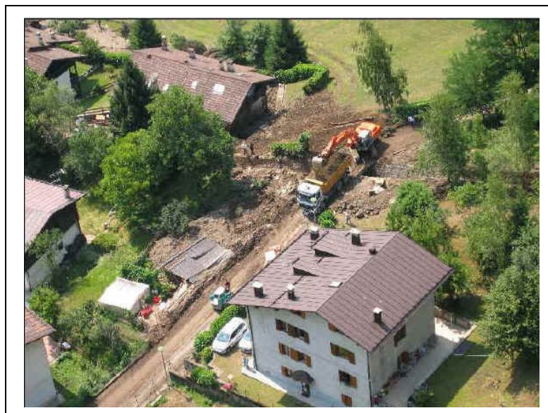
Figura 1.4: Frana nel Comune di Spiazzo
