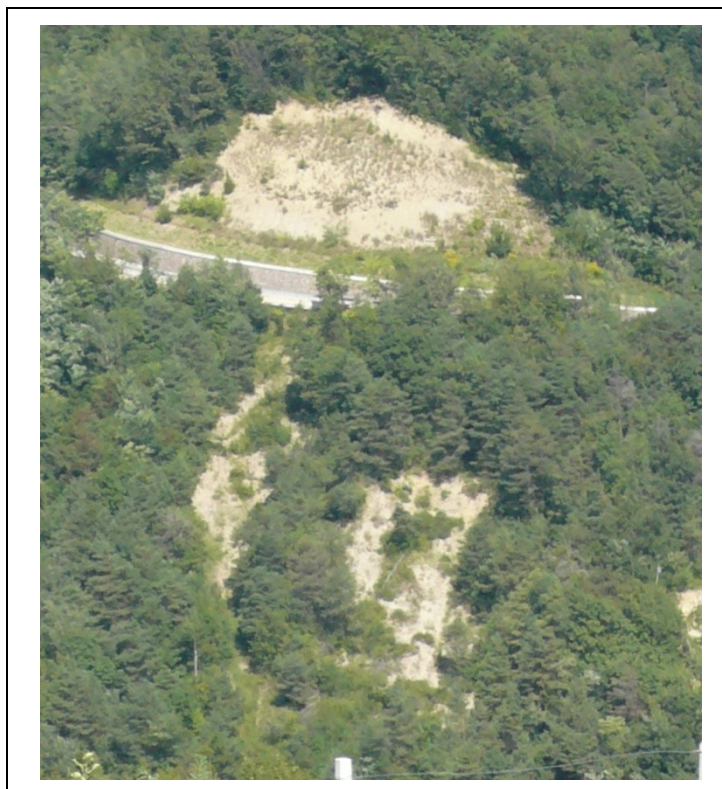
Figura 1.8: Frana superficiale nel Comune di Sporminore (TN)
