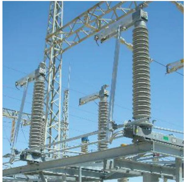
**Figura 36:Sezionatore a gomito orizzontale**
