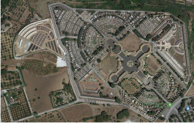
Figura 17. Cimitero del Paradiso, fotografia dall'alto.
