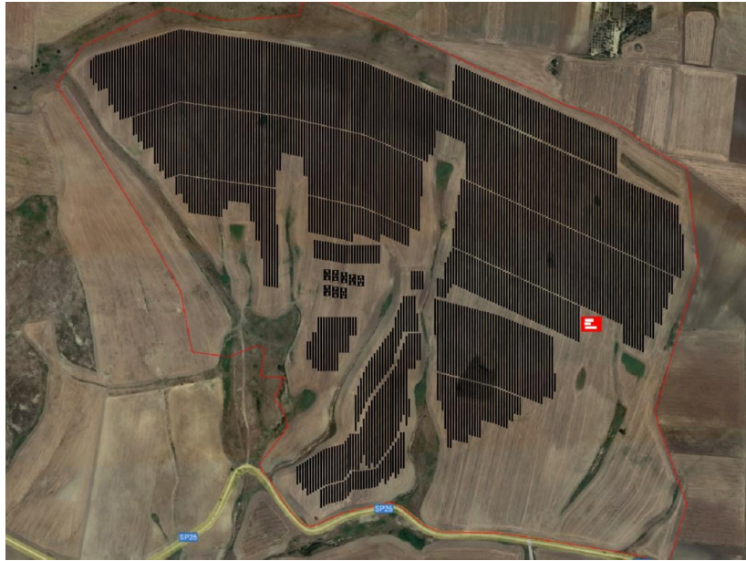
Figure 3.3. A possible PV plant layout in Gravina wind farm. Source: “Impianto Fotovoltaico Gravina in Puglia (BA), Relazione tecnico-informativa”. Ing. Alberto Voltolina.
