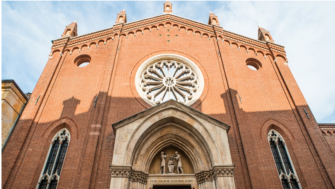
Fig.4: Facciata della chiesa di Santa Corona (Fonte: https://easyvi.it )
