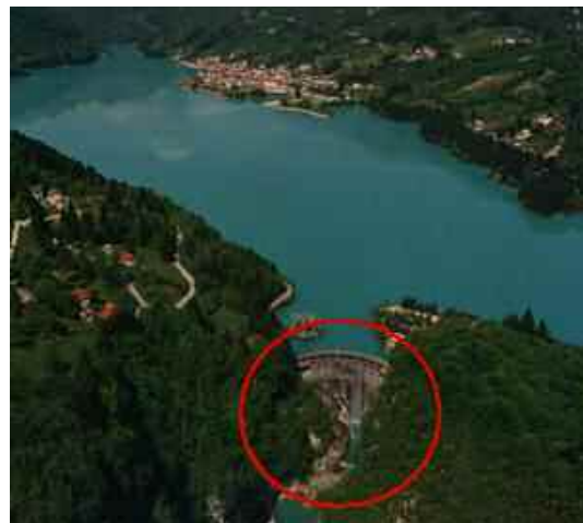
Fig. 5.2.3.2 La diga di Ponte Antoi
