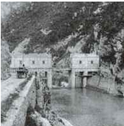
Fig. 5.2.3.1 La Vecchia diga
