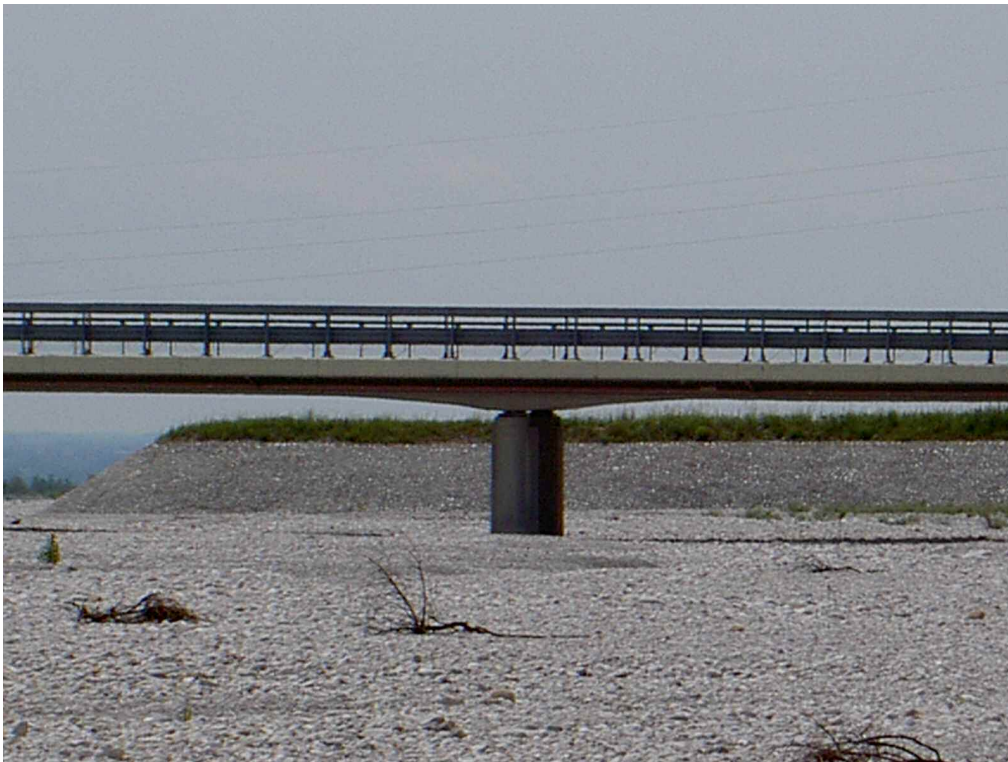
Fig. 2.5.2 Tratto del torrente a valle. Il ponte raffigurato è il Ponte Nuovo. Da notare l'assenza di vegetazione e la presenza di detriti legnosi
