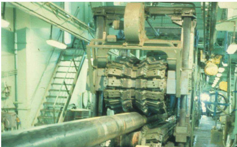
Fig. 3.1. Tensionatori in fasi di varo offshore: La condotta viene assemblata sulla nave in superficie e calata direttamente sul fondale marino. Il peso della struttura a “sbalzo”: grava interamente su dei cingoli gommati. Questo è un caso di posa particolare nella quale il rivestimento deve resistere alla forza di taglio e alla compressione dei cingoli, oltre che alle insidie del letto di posa, visto che in esercizio non sarà facilmente accessibile.
