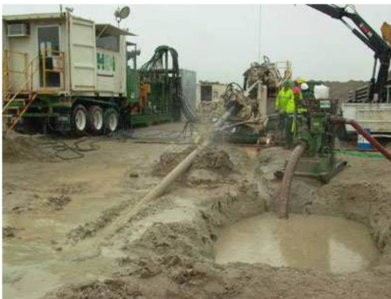
Fig. 3.2. Trivellazione Orizzontale Controllata: Il tubo viene agganciato e trascinato nel foro aperto dalla trivella. A causa della rotazione e del contatto diretto rivestimento-terreno la protezione applicata è di spessore maggiorato: in quanto viene considerata una determinata usura nel transito.
