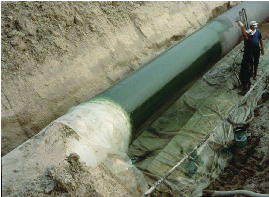
Fig. 3.6. Applicazione rivestimento resina termoindurente con sistema airless, su porzione di condotta in esercizio “da riabilitare”.
