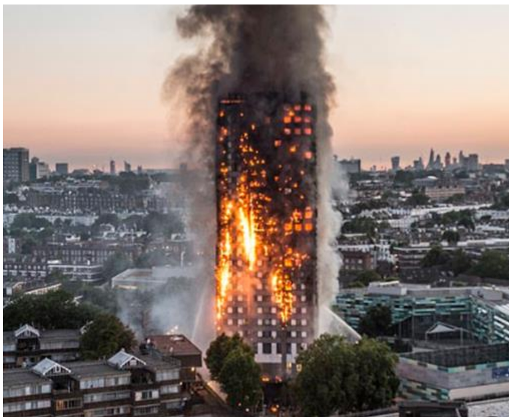
Figura 4.1. Immagine reale dell'incendio della Grenfell Tower
