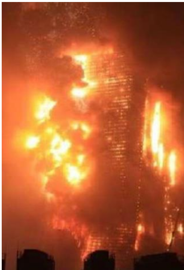
Figura 4.8. Immagine reale dell'incendio della TVCC
