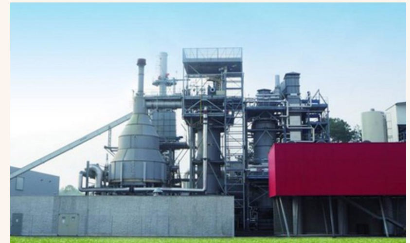
Impianto di Morcenx (Francia)
