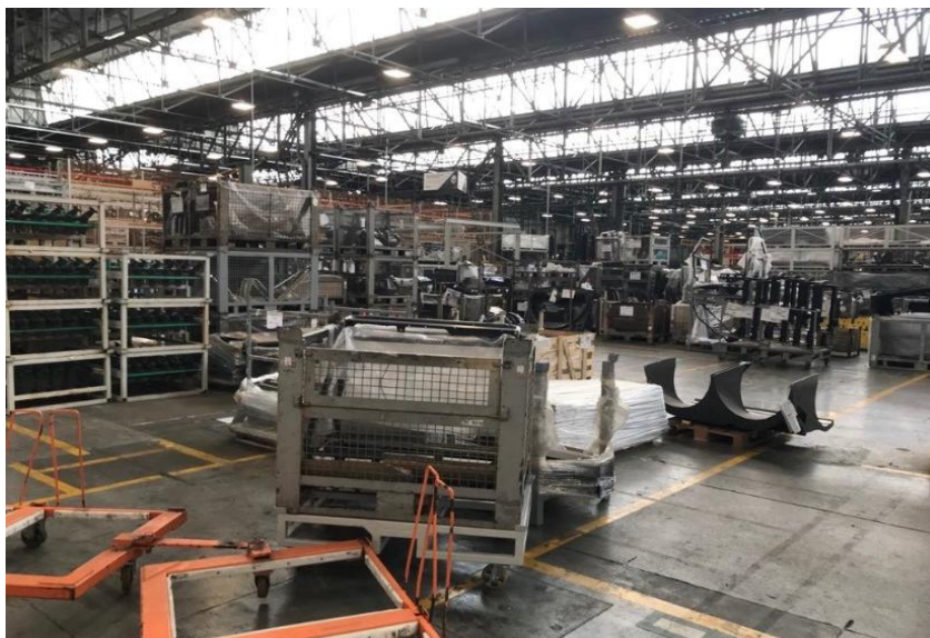
Figura 47 Immagine dello stato iniziale dell' area BPA
