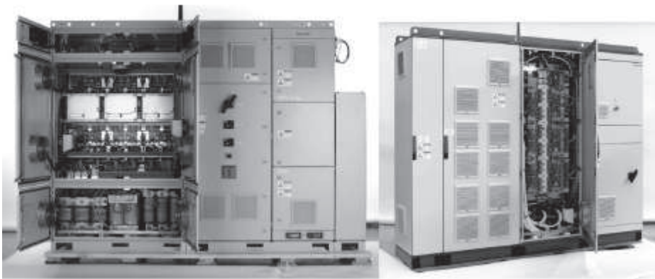
Figura 5.19: convertitore back-to-back a due livelli
