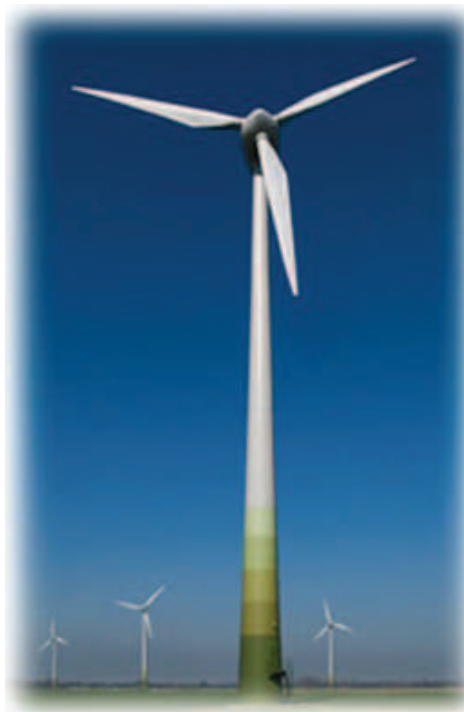
Figura 4.3: Turbina eolica con il sostegno
