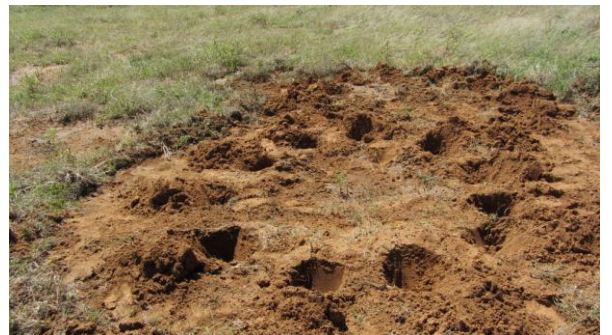
Figura 46: preparazione del terreno prima della costruzione della recinzione (Silvestri S.)
