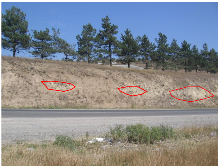
Foto 24: depositi quaternari esposti presso lo stop 14. Canali riempiti in evidenza.
