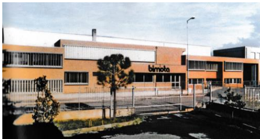
Figura 1.5: Lo stabilimento finito della nuova sede in via Giaccaglia a Rimini. Immagine tratta da [5].
