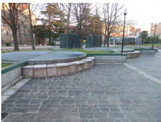
Figura 2.1. Piazzale esterno lato nord
