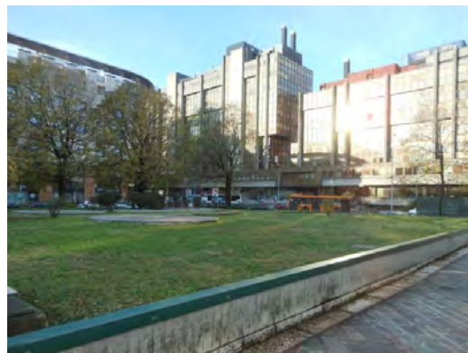
Figura 2.2. Piazzale esterno lato sud
