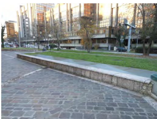
Figura 2.3 Piazzale esterno lato ovest
