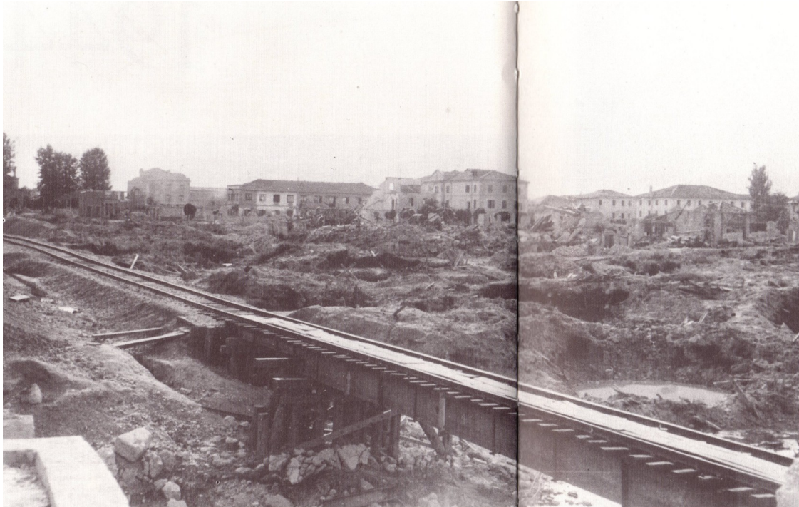
Figura 3.7: Sacile, 1944, Le devastazioni causate da centinaia di bombe, soprattutto lungo la linea ferroviaria Venezia-Udine e nella frazione di S. Odorico
