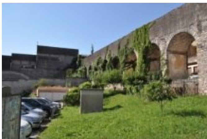
Figura 14. La Centrale Maglio (Valdagno) con le caratteristiche arcate del viadotto appositamente costruito per portare l'acqua alle turbine della stessa. Fonte: https://www.itinerarioenergia.it/territorio/energia/centrale-maglio/
