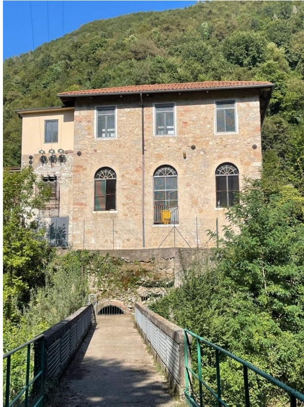
Figura 25. La Centrale Seladi vista dal ponte-canale sull'Agno (foto dell'autore, 2024)
