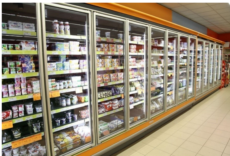
Figura 1.5: Banco frigo di un supermercato contenente prodotti alimentari confezionati la cui maggior parte di materiale plastico.
