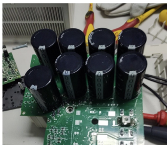
Condensatori di livellamento della tensione di ACS 355
