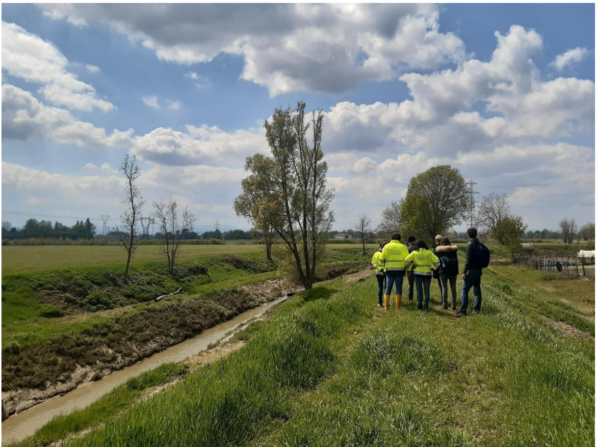
Fig.1.1 – Argini del torrente Grizzaga.
