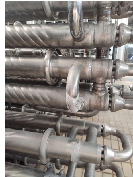
Tipi di scambiatore di calore usati in azienda (a tubo concentrico)
