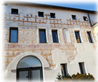
Fig.28 Facciata rivolta a sud del Palazzo della Pretura, Cittadella, PD.
