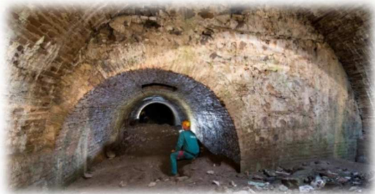
Fig.17 Cunicoli sotterranei, Cittadella, PD.
