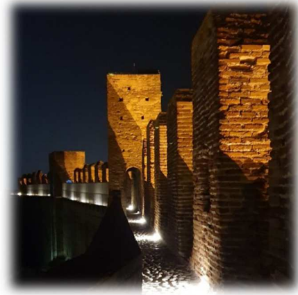
Fig.71 Vista del camminamento di ronda in notturno illuminato artificialmente con illuminazione a led, Cittadella, PD.
