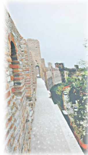
Fig.58 Camminamento di ronda in fase di restauro, Cittadella, PD.
