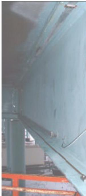
Figura 1.7: Sensore di strain posato lungo la struttura portante del ponte.
