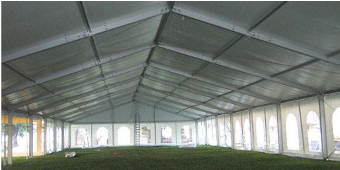
Tensostruttura a pianta rettangolare - vista interna
