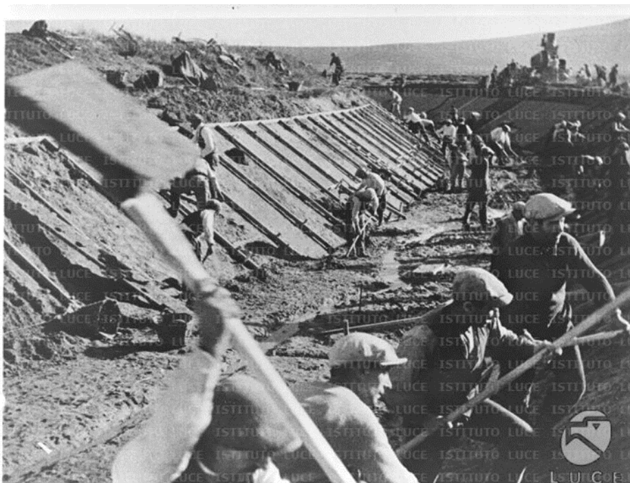
8 Operai al lavoro sul cantiere di canalizzazione.
