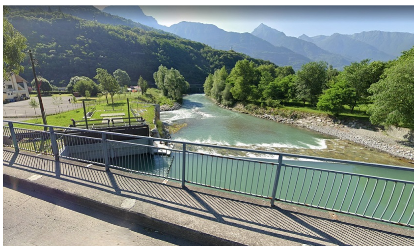
Figura 1.7: Fotografia della sezione di ingresso della centrale
