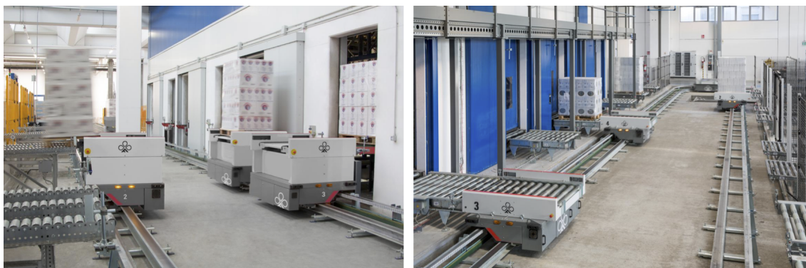
Figura 3.7: Due esempi impiantistici dell' Handling Shuttle Fast Ring di Ferretto Group.
