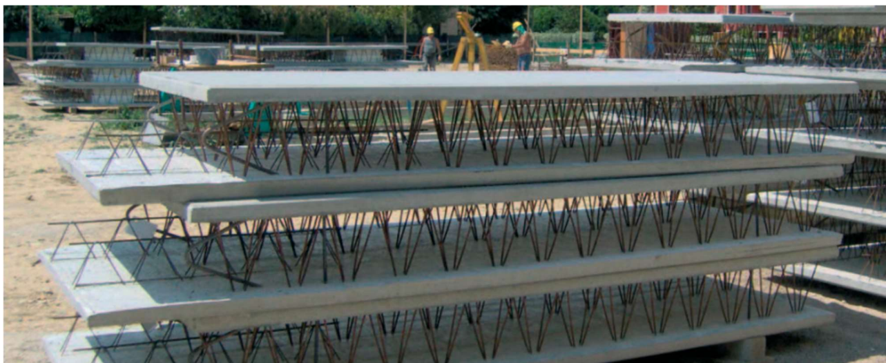
Figura 2.2.1 – BILASTRE® stoccate in cantiere
