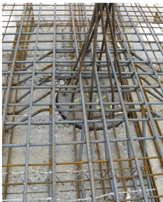
Figura 2.1.2 – armatura a punzonamento
