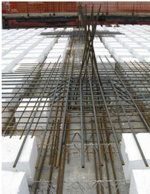
Figura 2.1.1 – armatura in prossimità di un pilastro
