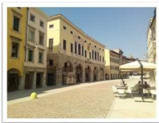
Fig.2.6 - Il Palazzo del Monte di Pietà visto da via Mercatovecchio
