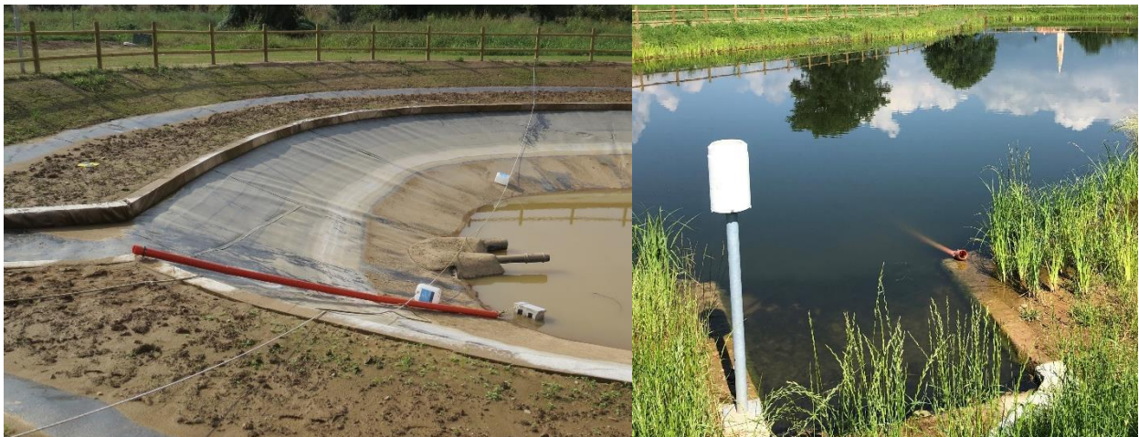
Figura 19: Il tubo in PVC forato installato sulla sponda del bacino che ospita il trasduttore di pressione per misurare il livello dell'acqua, (Report terzo anno)
