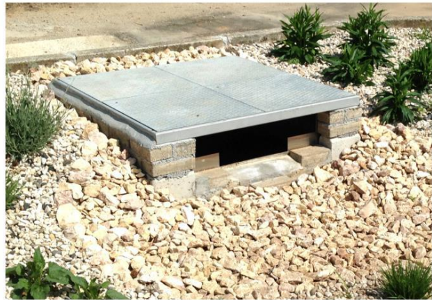
Figura 16: Disegno prospettico dello sbarramento (a sinistra, valori in millimetri) e immagine della sua installazione nella fossa di cemento che funziona come stagno di stramazzo (a destra), (Report terzo anno)
