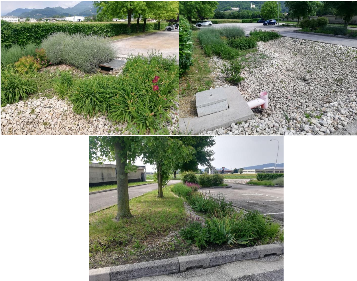
Figura 11: Rain garden Via dei Prati in maggio 2023
