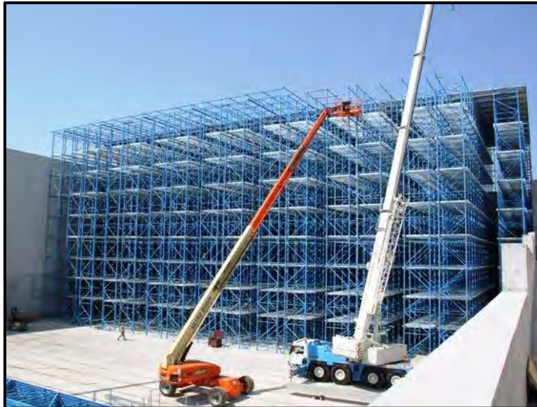
Figura 5: scaffalature industriali realizzate con profili formati a freddo
