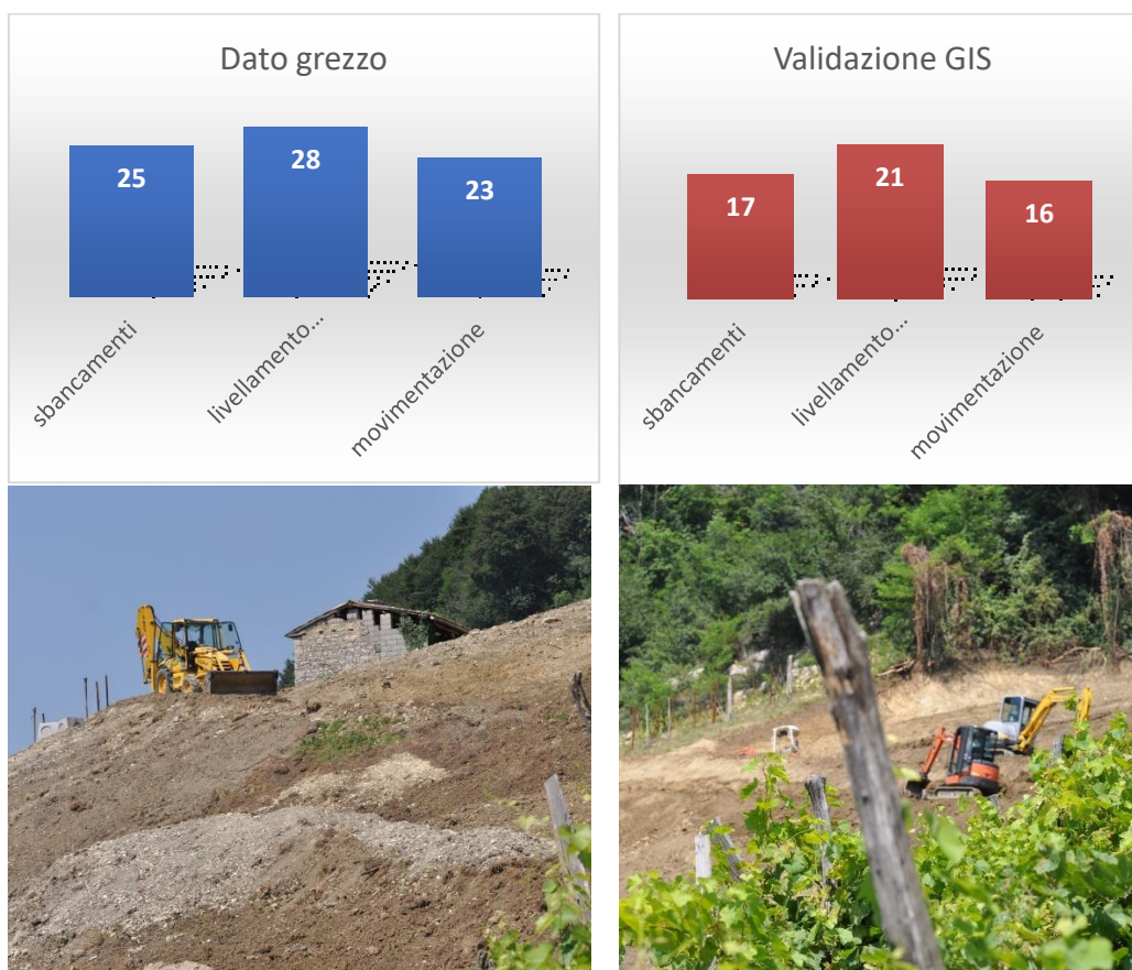
Figura 25: Tipi di modificazione alla morfologia del terreno (foto scattate il 12/7/2020).
