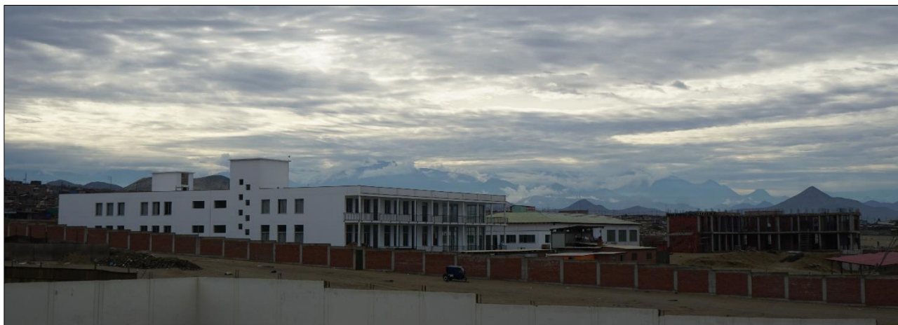
Fig 4. Vista laterale sul terreno dell'istituto "Scuola Totale Padre Ugo De Censi". Al margine sinistro della foto si può notare la scuola primaria (edificio bianco), portando lo sguardo verso destra si intravede la mensa scolastica (edificio con copertura di color verde) ed infine avvicinandoci al margine destro della foto si vede un quarto della struttura della scuola secondaria, in costruzione da quest'anno (Foto di Jacopo Bertolotto, Marzo 2023).
