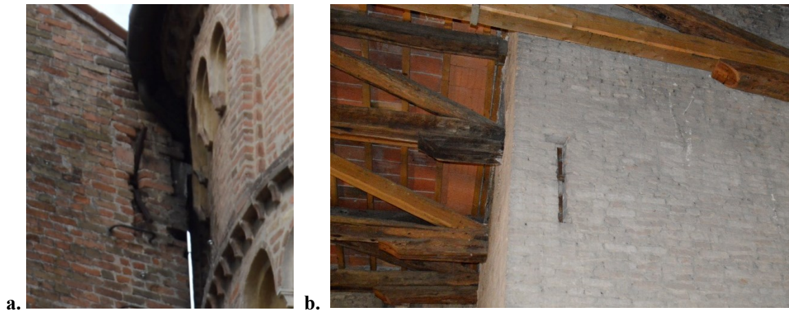
Figura 3.51 – a. Tirante longitudinale Cattedrale; b. Tirante trasversale Cattedrale
