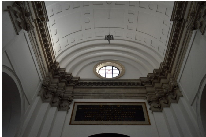
Figura 4.15 - Volta a botte che copre la navata centrale
