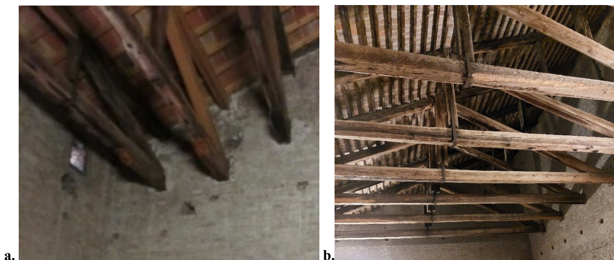
Figura 3.35 - a. Reticolari lignee navata laterale nord; b. Capriate zoppe navata laterale sud
