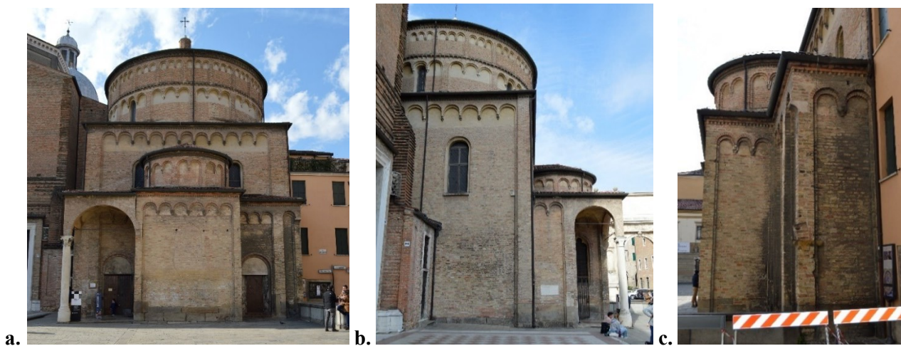
Figura 3.4 - a. Prospetto Est Battistero; b. Prospetto Sud Battistero; c. Prospetto Nord Battistero
