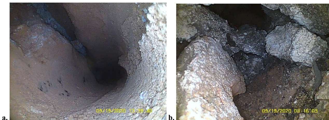
Figura 3.21 - a. Videoendoscopia lanterna sommitale; b. Videoendoscopia parete del tamburo
