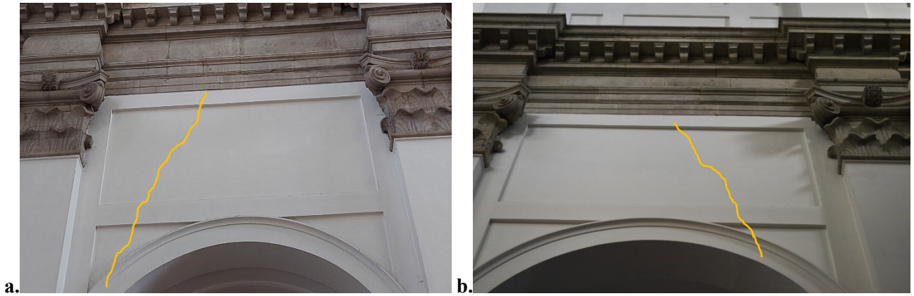
Figura 6.31 - a. Lesione arco trasversale; b. Lesione arco longitudinale
