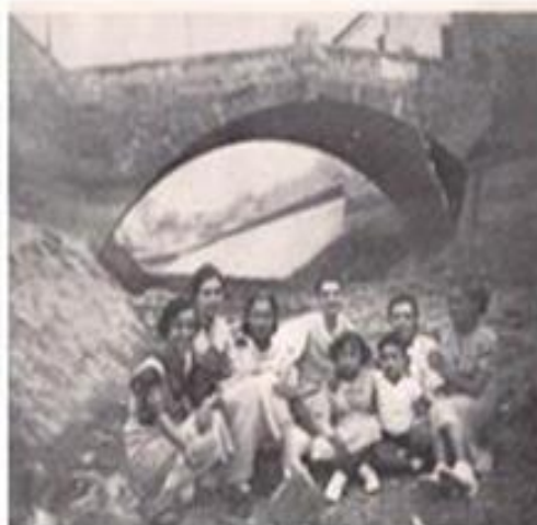
Ponte della Grolla tra le due guerre. Foto di gruppo (Foto Zangrossi)
