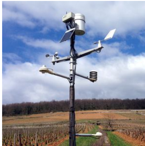
Stazione meteorologica utilizzata per il controllo dei parametri atmosferici
