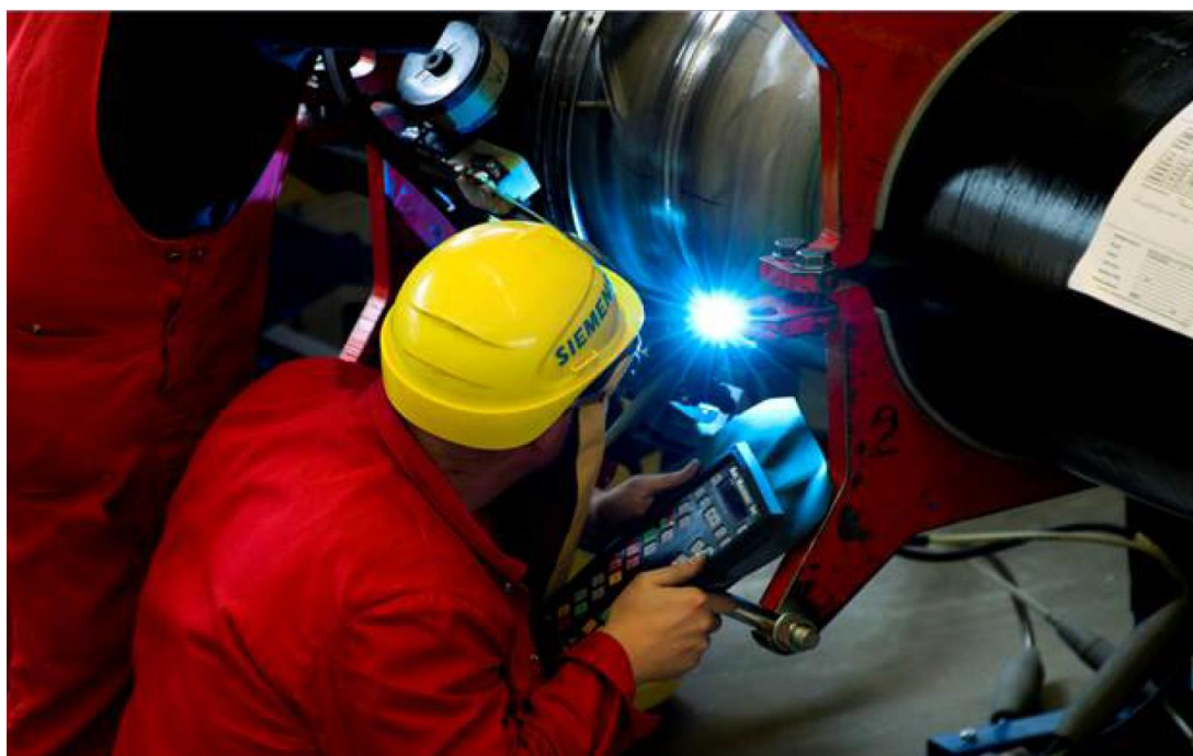
Figura 19 - Tecnici che eseguono una saldatura tra due GIL
