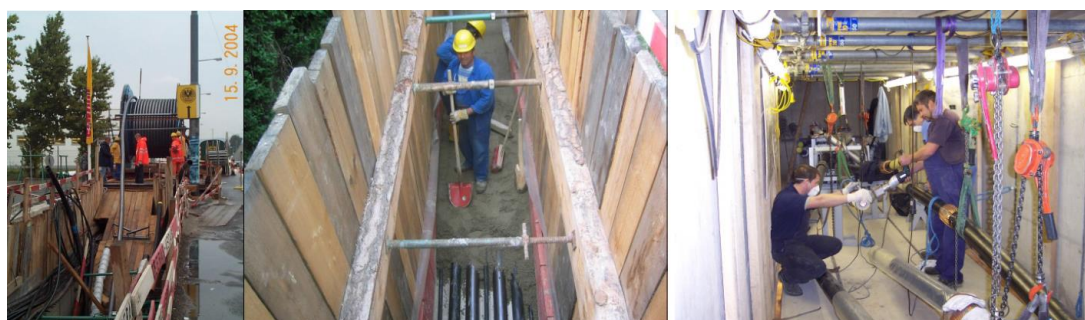
Figura 8 - Foto del lavoro di scavo per la posa dei cavi
