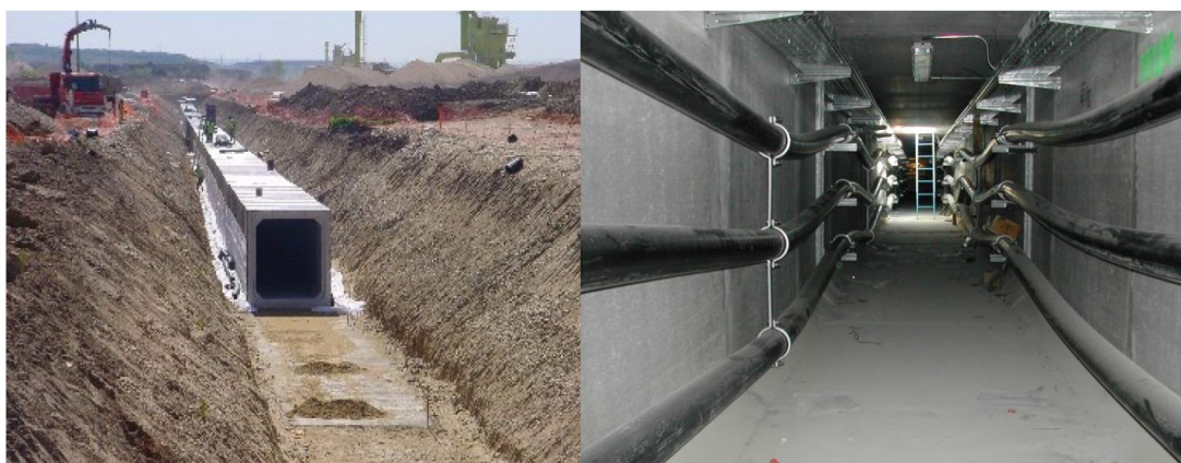
Figura 11 - Installazione dei cavi nel tunnel
