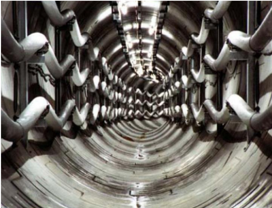
Figura 28 - Posa in tunnel di una doppia terna di cavi.
