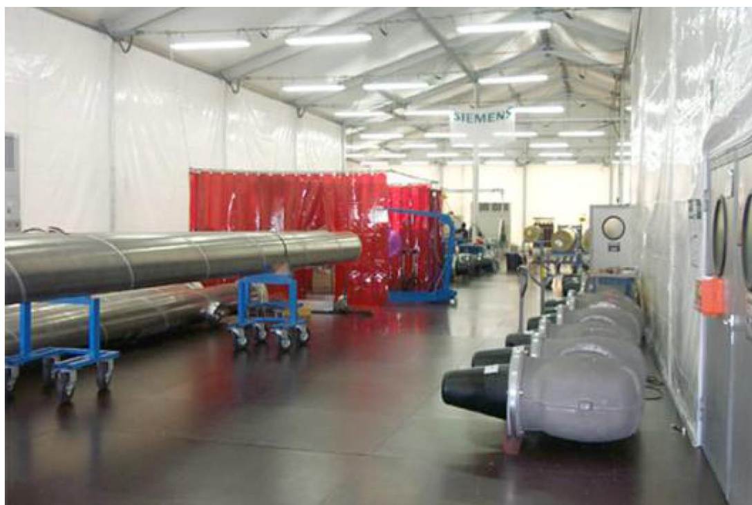
Figura 18 - Sito di saldatura dei GIL
