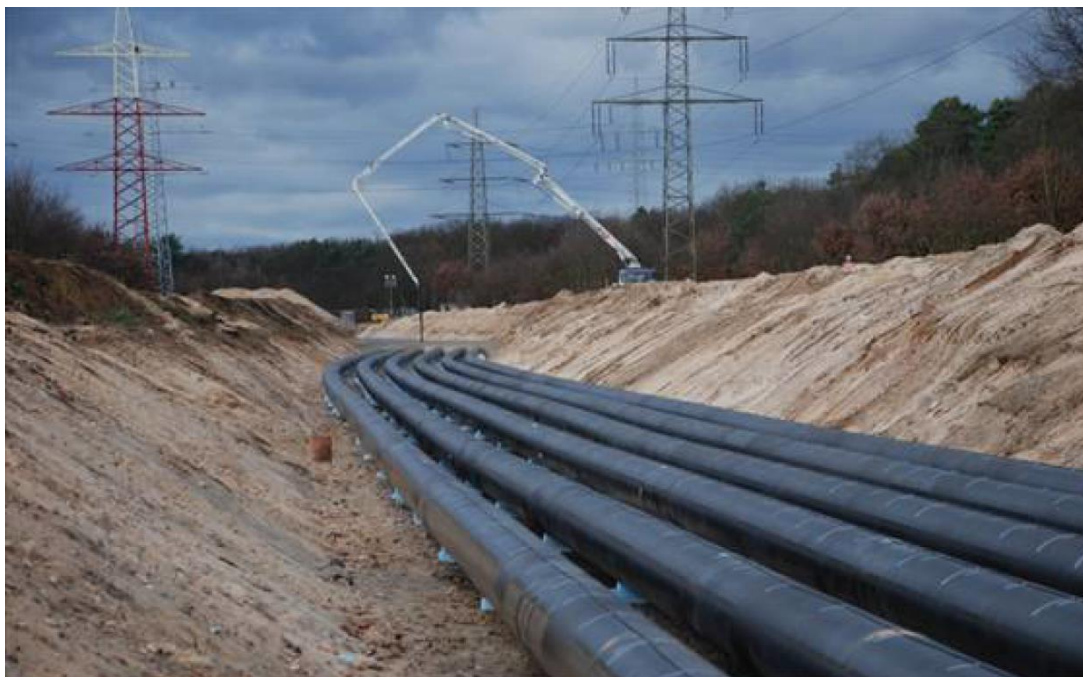
Figura 20 - GIL installati prima della copertura
