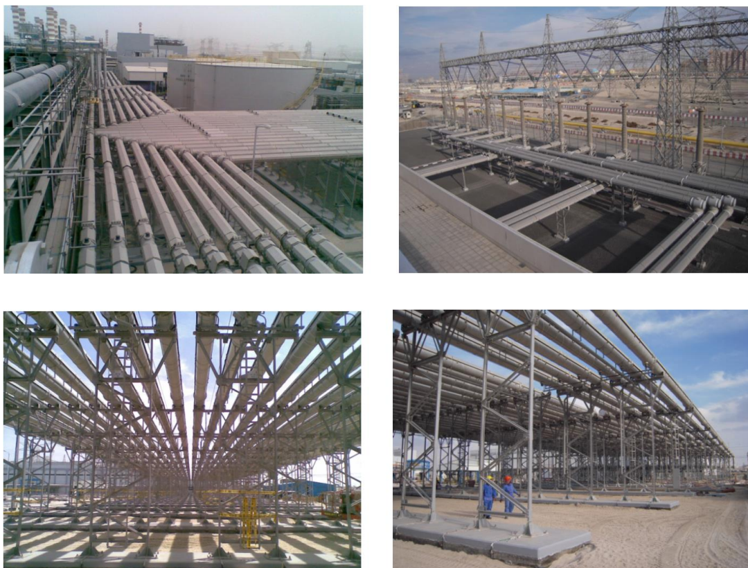
Figura 2 - Installazioni di GIL in centrali
