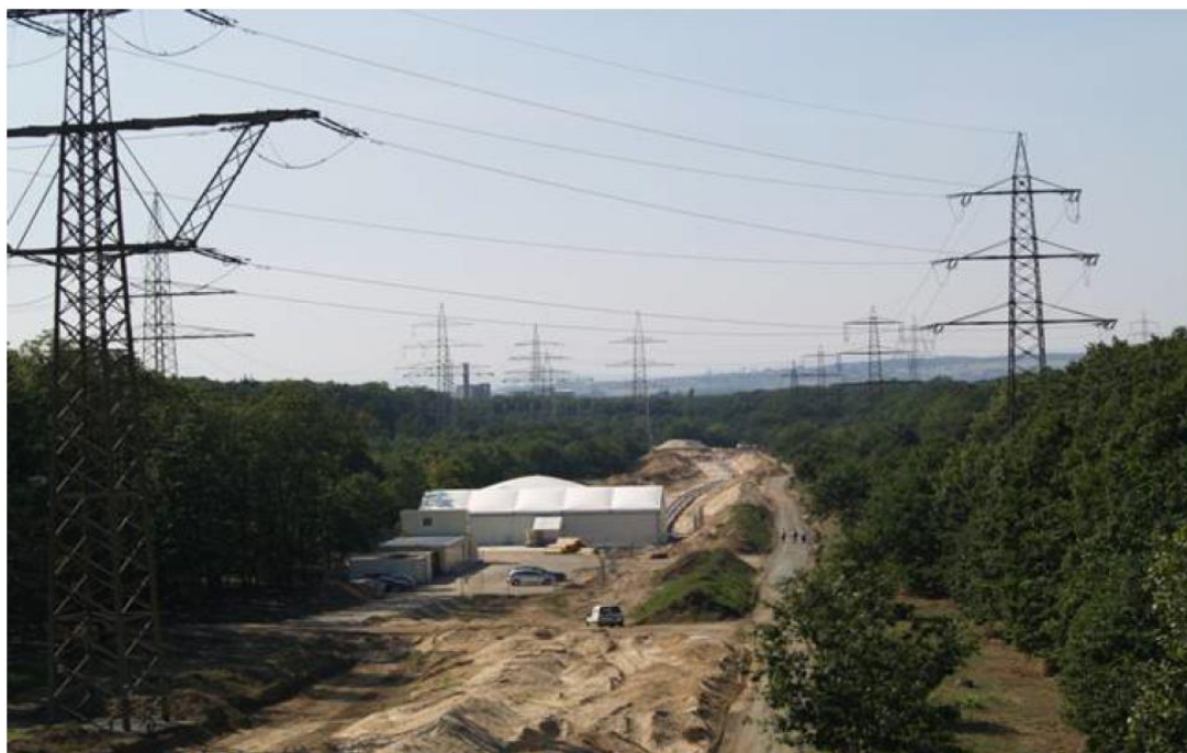
Figura 17 - Posa direttamente interrata a Kelsterbach
