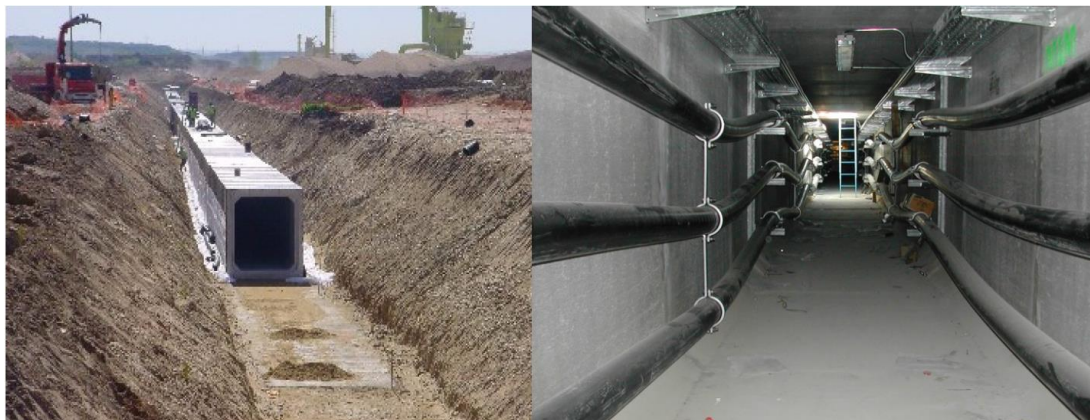
Figura 27 - Posa di una doppia terna in tunnel di cemento interrato
