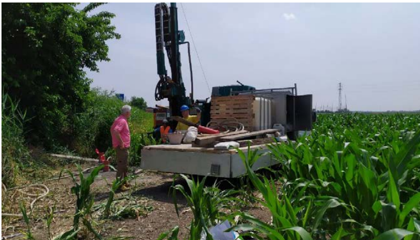
Fig. 2.10: Strumentazione usata per l'esecuzione dei carotaggi MoST.
