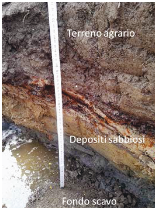
Figura c: Foto di una parete dello scavo eseguito durante la posa del dreno.
