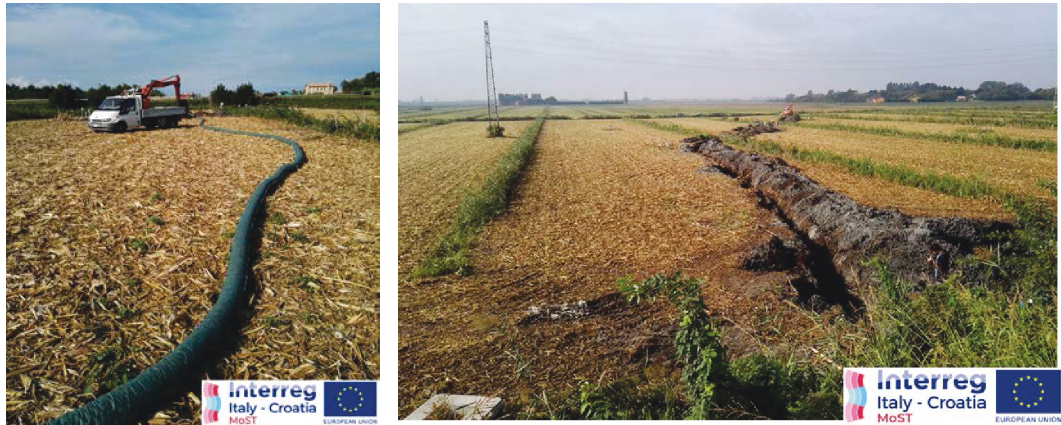
Figura b: Fotografia del dreno prima dell'interramento, e dello scavo della trincea.
