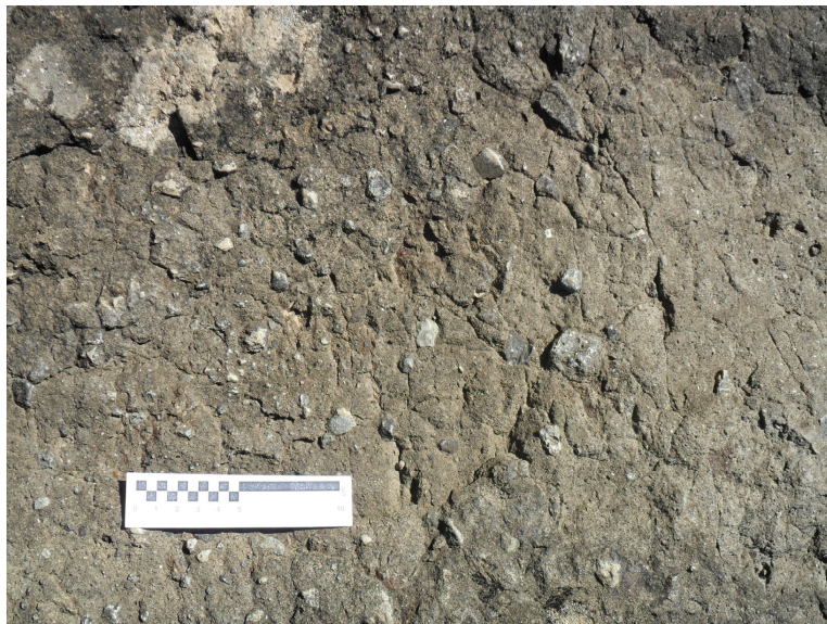
Figura 20 Area demolita con grani bianchi di pomice in situ.
